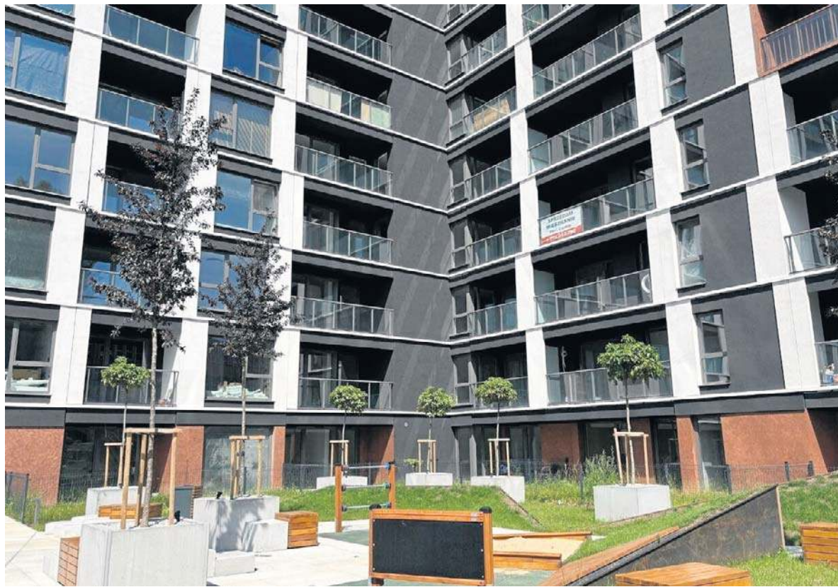
Zakończono budowę nowoczesnych mieszkań Panorama Struga w Radomiu. To jedna z największych inwestycji mieszkaniowych powstających w ostatnich latach w Radomiu.
