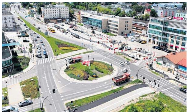
Od 1 sierpnia, na skrzyżowaniu Żelaznej, Czarnowskiej i Gosiewskiego miejsce sygnalizacji świetlnej zajmie tymczasowe rondo
