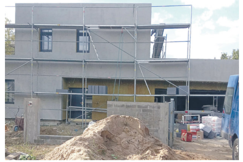
Budowa domu w Stoku Lackim
