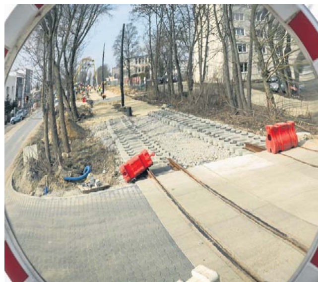
Prace przy inwestycji mają zakończyć się na początku 2027 r.
