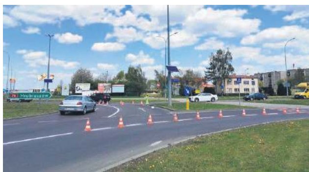
Nowe oznakowanie poziome ronda wykonano w zeszłym tygodniu. Fot. UM Zamość
