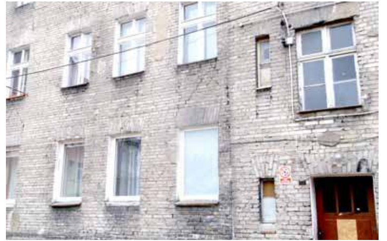
Budynek przy ul. Wojska Polskiego 78A nigdy nie był ocieplany. Zdjęcie wykonano w lutym 2016 roku
