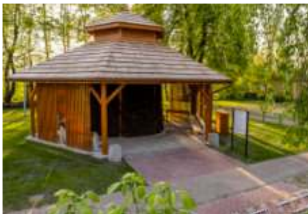
► Tworzenie tężni solankowych Fot. UM Zabrze
