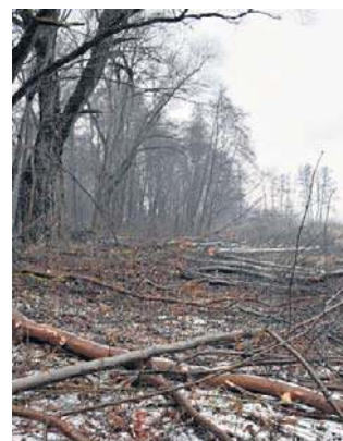
budowa ma się zakończyć do sierpnia 2026 roku.
