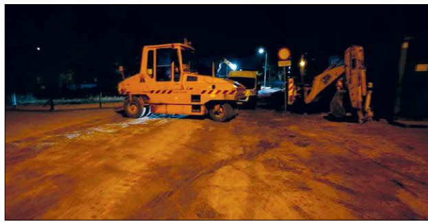
Mieszkańcy sygnalizują, że zmiana organizacji na budowanym odcinku ul. Ceglanej nie jest ustalana wcześniej, przez co niezapowiedziane blokady przejazdów dezorganizują im poruszanie się po osiedlu
