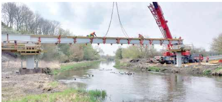
Obecnie ekipy budowlane koncentrują się na spawaniu styków, czyli trwałym łączeniu ułożonych wcześniej segmentów konstrukcji
