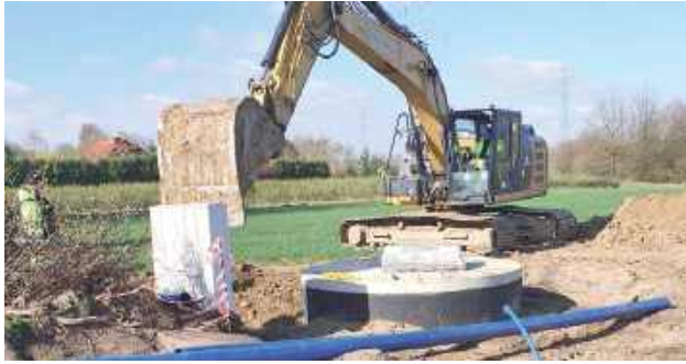
Gmina Spiczyn kontynuuje rozbudowę swojej infrastruktury technicznej, uruchamiając trzeci etap modernizacji sieci wodociągowej, która ma zapewnić mieszkańcom stabilne dostawy wody o odpowiednich parametrach
