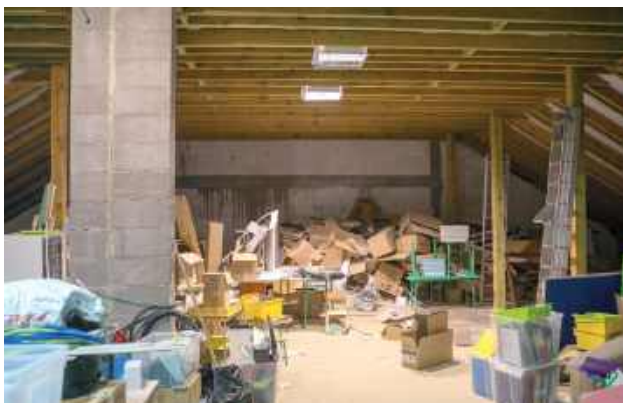
Jeszcze niezagospodarowane poddasze w szkole w Zofiówce
