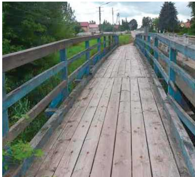
Stan kładki przed remontem
