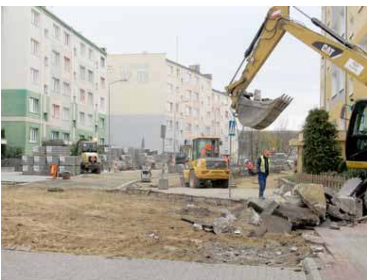
Prace na ulicy 11 Listopada ruszyły z rozmachem. Niestety, w środę wykonawca bez ostrzeżenia zamknął jednokierunkową ulicę dojazdową od ul. Krasińskiego
