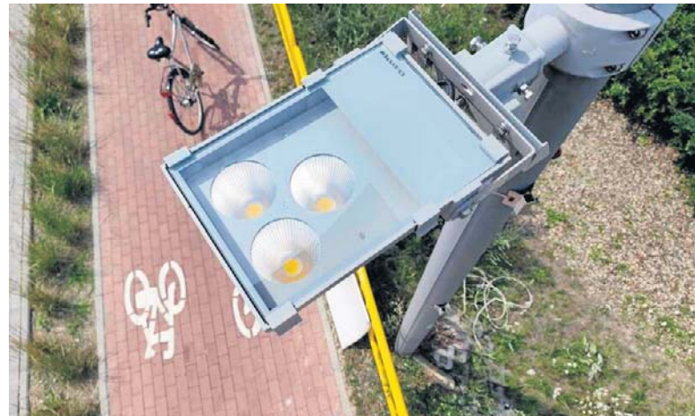
Montaż nowego oświetlenia ma zakończyć się w sierpniu
