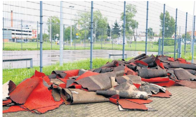
W marinie zerwano starą nawierzchnię kortu tenisowego
