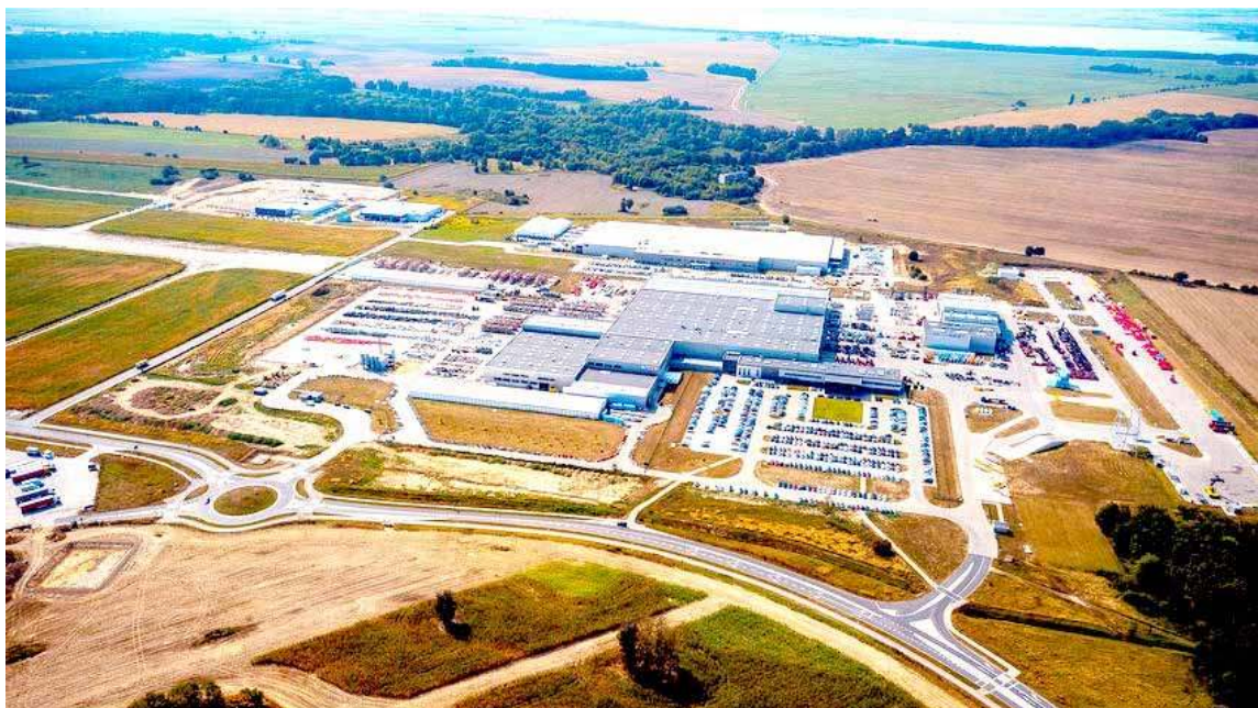
Pierwszy etap uzbrojenia Parku Przemysłowego Nowoczesnych Technologii otrzymał dofinansowanie w wysokości 3 739 755 zł
