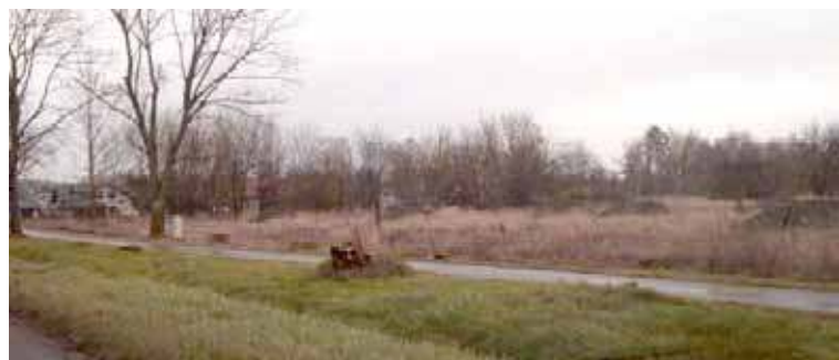
Na odcinku Kobylanka-Morzyczyn wykonano wycinkę drzew i krzewów przy ścieżce rowerowej
