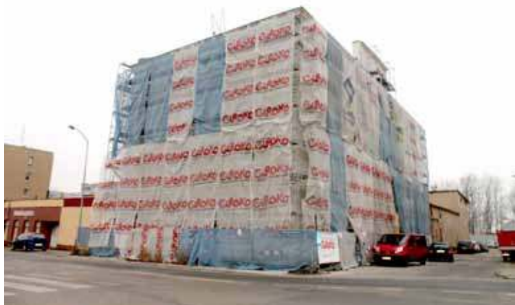
4 mln zł dofinansowania ze środków unijnych otrzymała budowa Stargardzkiego Centrum Nauki
