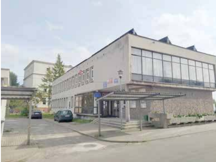
Jednym z trzech budynków, gdzie ma zostać przeprowadzony remont to stary budynek laboratorium
