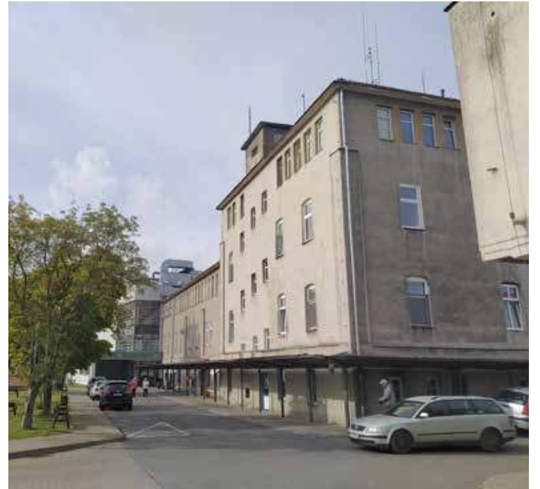
Po przeprowadzeniu prac widok starej części szpitala zmieni się nie do poznania
