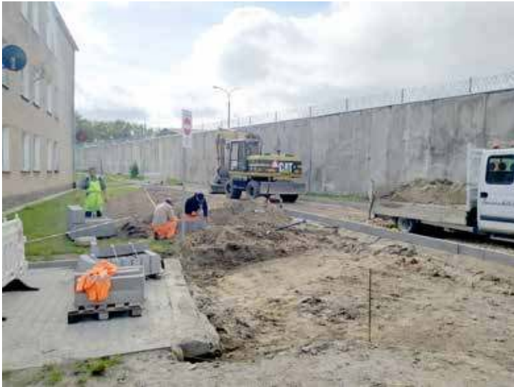
We wtorek pracownicy firmy na zlecenie UM Nowogard wykonywali korytowanie przebiegu drogi. Wszystkie prace mają zakończyć się do końca przyszłego tygodnia
