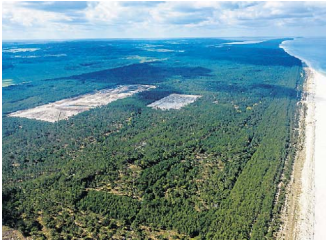
Teren przyszłej pierwszej elektrowni atomowej w Polsce Lubiatowo - Kopalino
