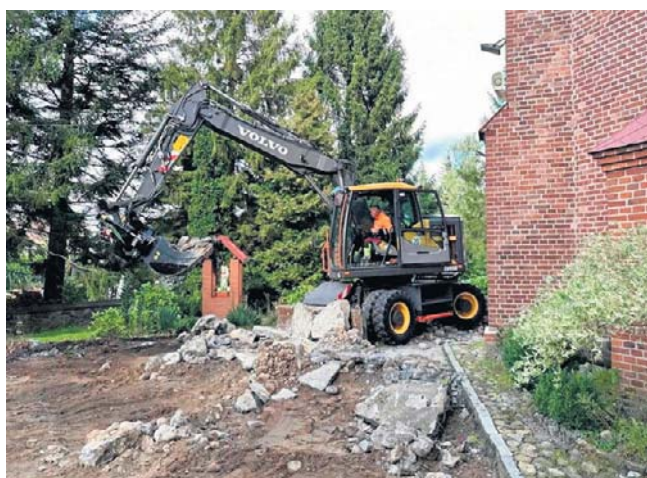
Prace przy kościele w Damnie
