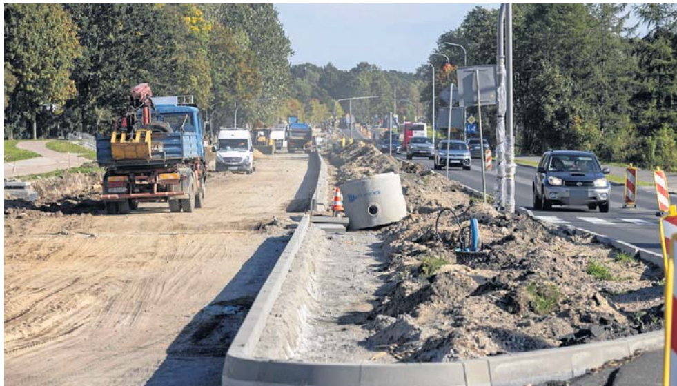
Wraz z budową drogi Redzikowo-Jezierzyce modernizowana jest także droga przelotowa przez Redzikowo
