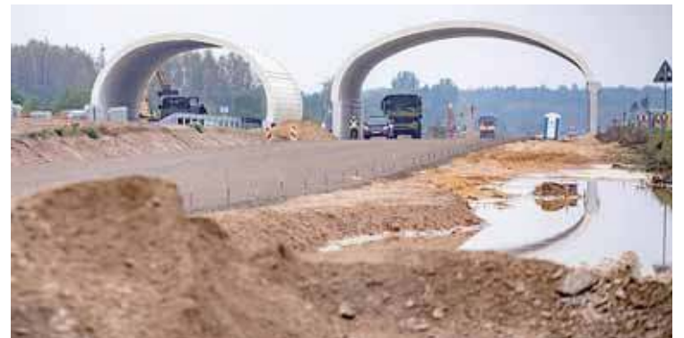
Na łączącym ok. 35 km odcinku powstanie około 40 obiektów inżynierskich, głównie wiaduktów
