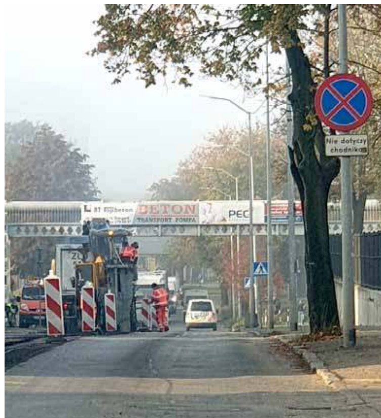
We środę firma Strabag rozpoczęła przebudowę ulicy na odcinku skrzyżowania z ulicą Ceglana. Stoją!Stargard
