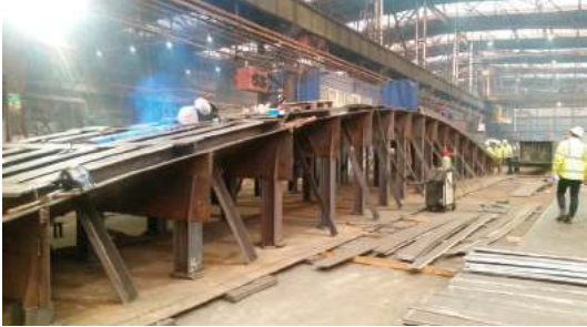
Hutnicy z Rudy Śląskiej pracują non stop przy budowie infrastruktury dla Parku Ludowego w Lublinie
