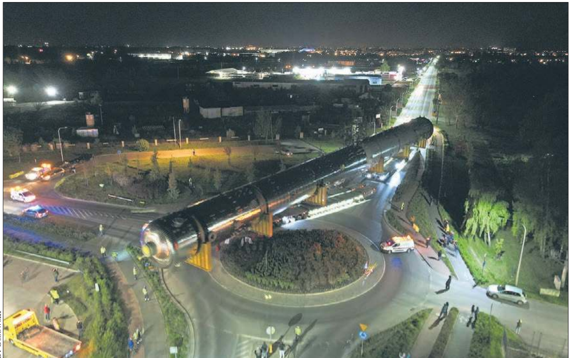
Transport Wash Tower wymagał szeregu zmian w infrastrukturze, m.in. przebudowy rond czy modyfikacji linii energetycznych
