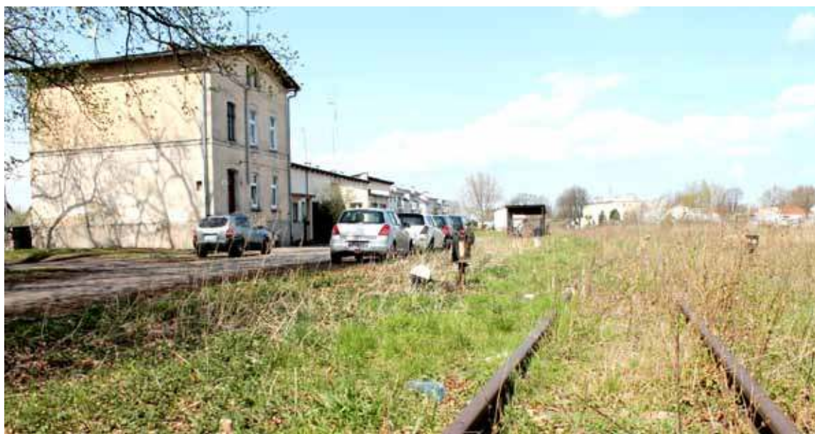
Niestety, na chwilę obecną stacja na Brzozowej wraz z torami nie wyglądają zachęcająco
