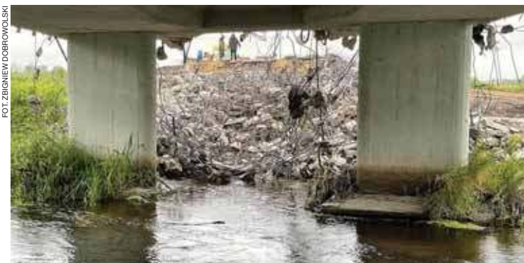
Most w Bieżuniu został wyburzony na początku sierpnia, jednak do tej pory nie wydano pozwolenia na budowę przeprawy tymczasowej w tym miejscu
