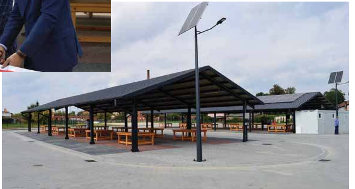
Zmodernizowany obiekt posłuży lokalnym handlarzom i społeczności.
