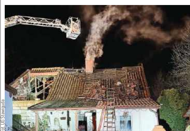
Pożar domu rodziny Balcerzaków ze Stawigudy
