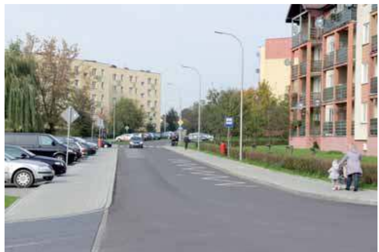
Zmodernizowana ul. Witwickiego na OKM
