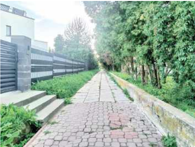
W tym miejscu ma powstać nowy, równy chodnik i ścieżka rowerowa
