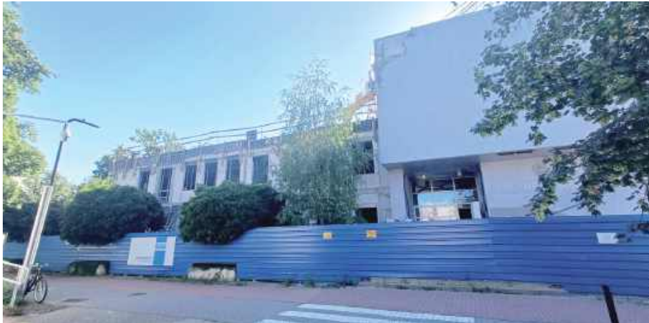
Cały plac budowy został szczelnie ogrodzony przez wykonawcę. Ale po kilku miesiącach robót już widać górujące nad ogrodzeniem nowo wybudowane części sądu
