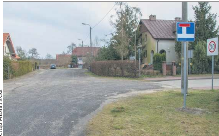
Modernizacja sięgacza ulicy Cedrowej potrwa osiem miesięcy
