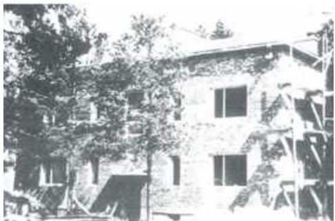
Budowa jednego z obiektów przy dzisiejszej ul. ks. Skoczynskiego.
