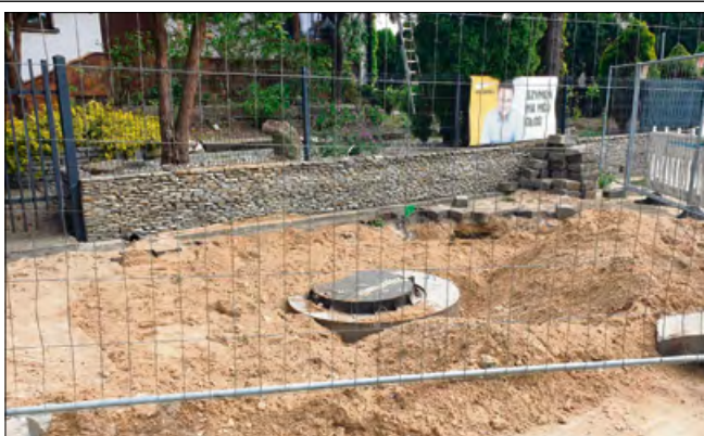
Z pracami związane są utrudnienia w ruchu.
