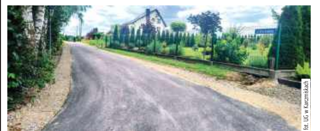
Przebudowany odcinek łączy drogę powiatową - ul. Polną z ul. Lubelską
