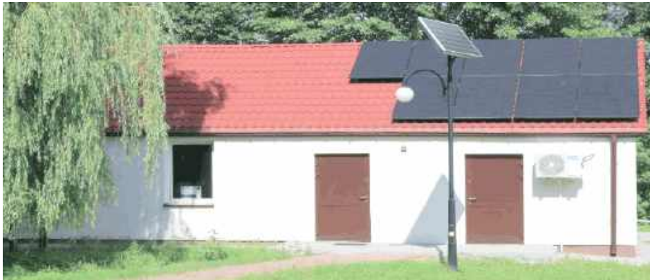
Tak po remoncie prezentuje się świetlica wiejska w Zastawkach
