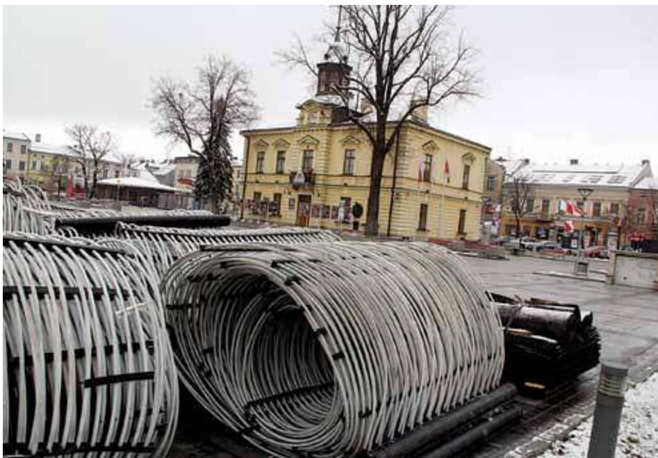
Instalacja już przywieziona - lodowisko wkrótce znów powstanie na nowotarskim Rynku.
