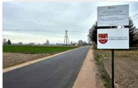
Droga powiatowa nr 3639W w miejscowości Modrzew
