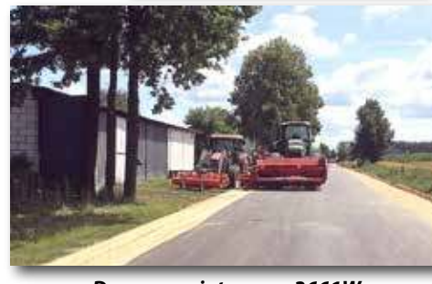
Droga powiatowa nr 3661W w miejscowości Wólka Proszewska
