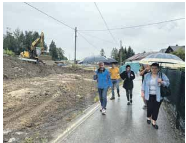
Rabka to wielki plac budowy.
