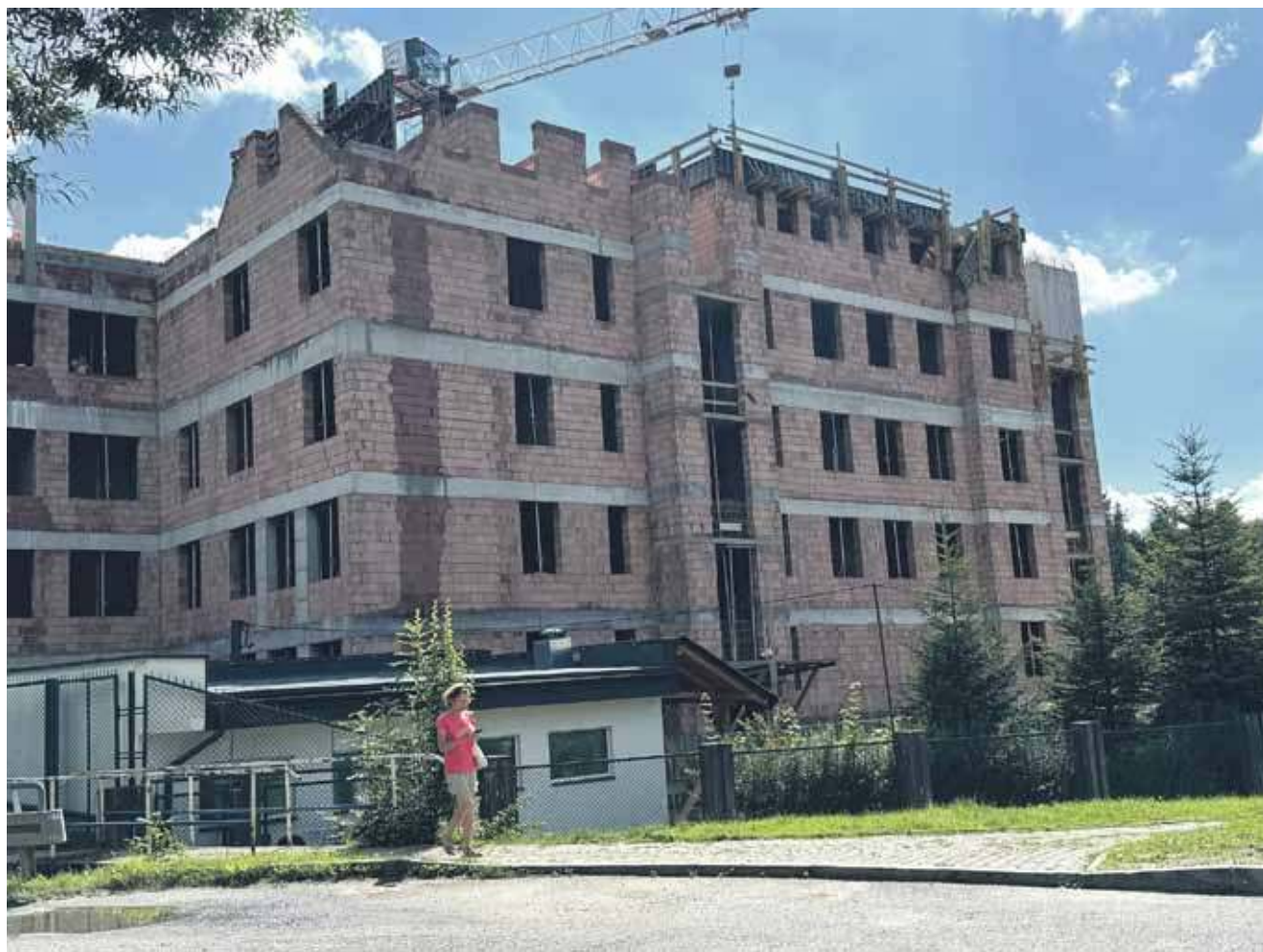
Mury gotowe, teraz pora na ostatnie stropy i dach...
