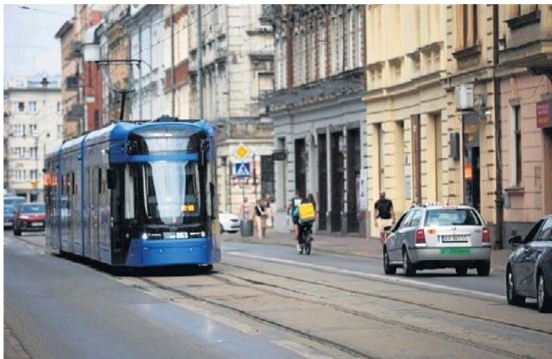
Ulica Starowiślna jest w fatalnym stanie. Potrzebuje modernizacji
