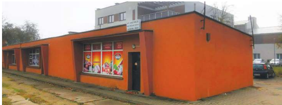
W miejsce pawilonu powstanie parking dla gości GOK-u
