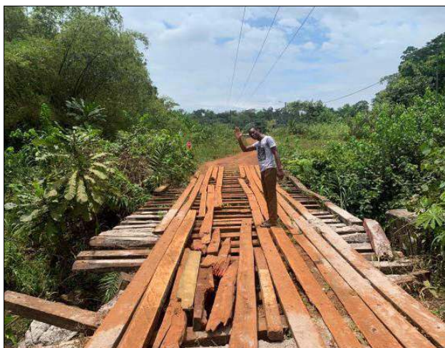
Drogi w Gabonie są często w opłakanym stanie, na zdj. droga do Cocobeach
