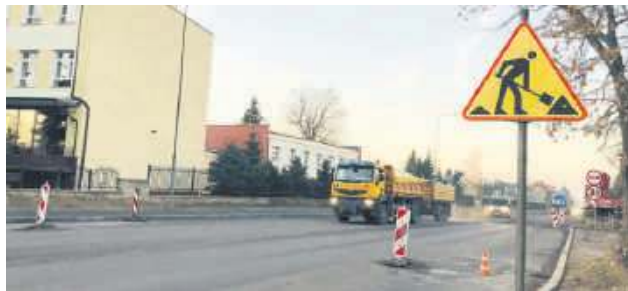
Pierwotnie zakładano, że na ul. Orłąt Lwowskich zostanie przebudowany tylko odcinek bezpośrednio przy nowym rondzie. Fot. A. Szewc
