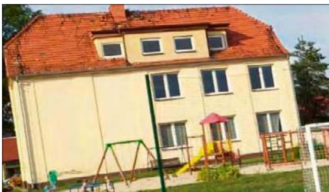
Budynek świetlicy wiejskiej w Dobieszowicach zostanie wyremontowany.
