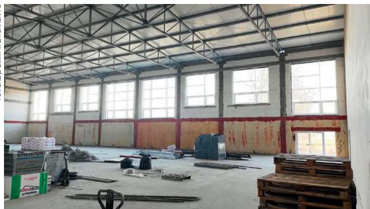
Trwają prace wykończeniowe
