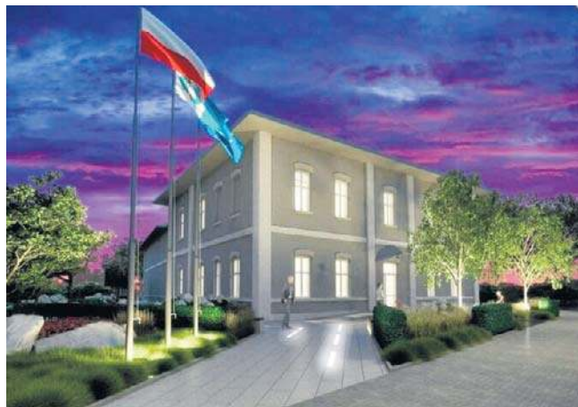
Tak będzie wyglądał urząd gminy w Chełmcu po remoncie. Prace zakończą się w październiku
