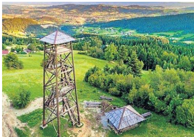
Przy starej wieży, która zostanie rozebrana, jest pole biwakowe i grill. To miejsce ma przejść metamorfozę
