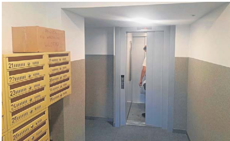
Nowe wejście do windy w jednym z wieżowców przy ulicy Świętopełka - tak jak w pozostałych powstało na poziomie -1
