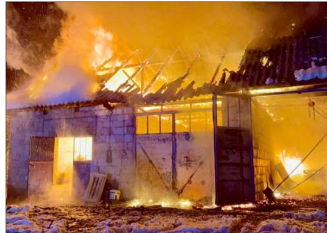
Pożar objął cały budynek gospodarski.
