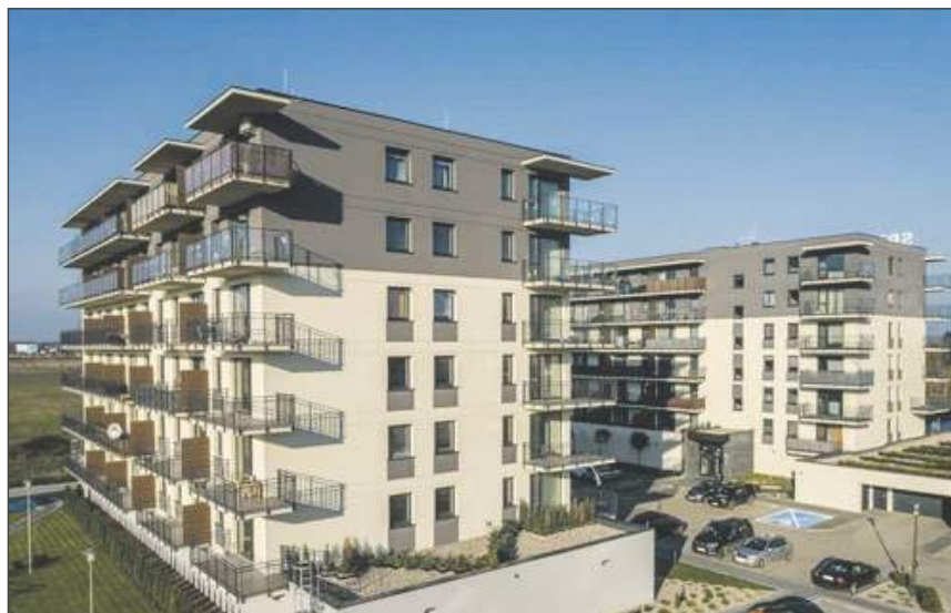
➤ Budowa budynku nr 8 na osiedlu Zamojskiego w Garwolinie (developer: Grupa Ochnik Inwest)
