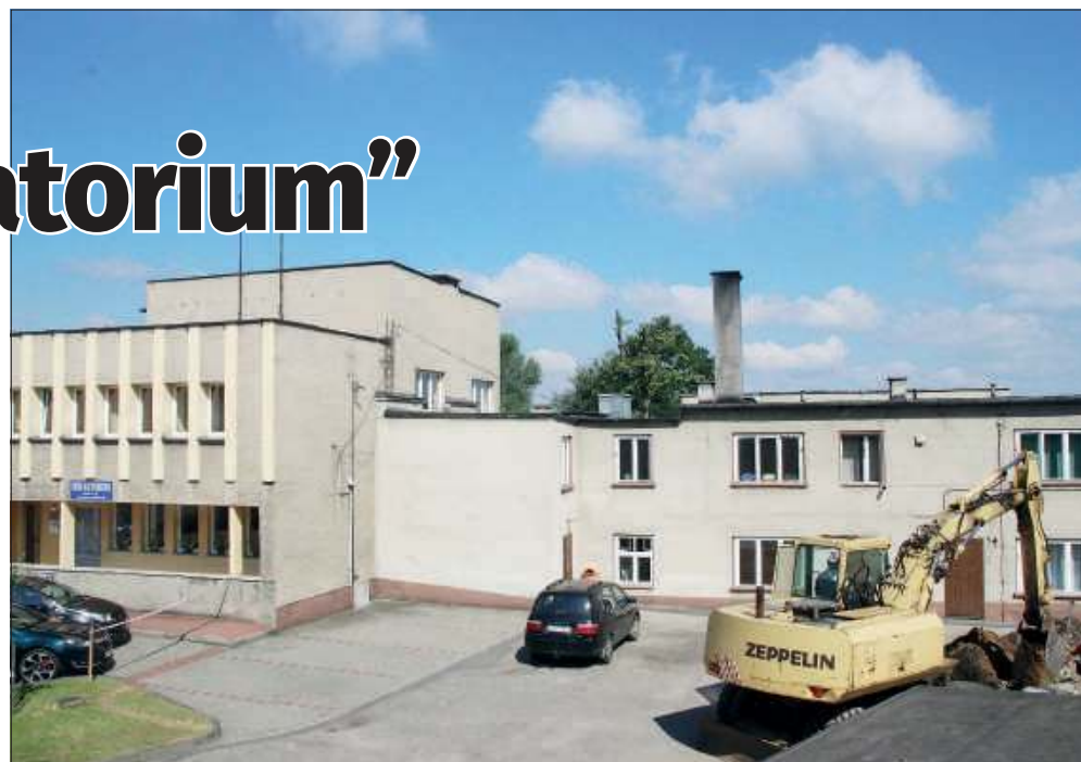
To siedziba Zakładu Gospodarki Komunalnej i Mieszkaniowej w Kuźni Raciborskiej. Po prawej stronie widoczny jest budynek z kominem, czyli część, która zostanie wyburzona.
