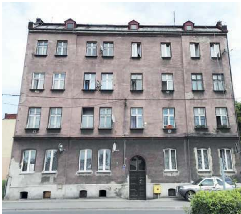
Kamienica przy ul. Fabrycznej w Raciborzu – tak wygląda dziś, a tak ma wyglądać po remoncie
