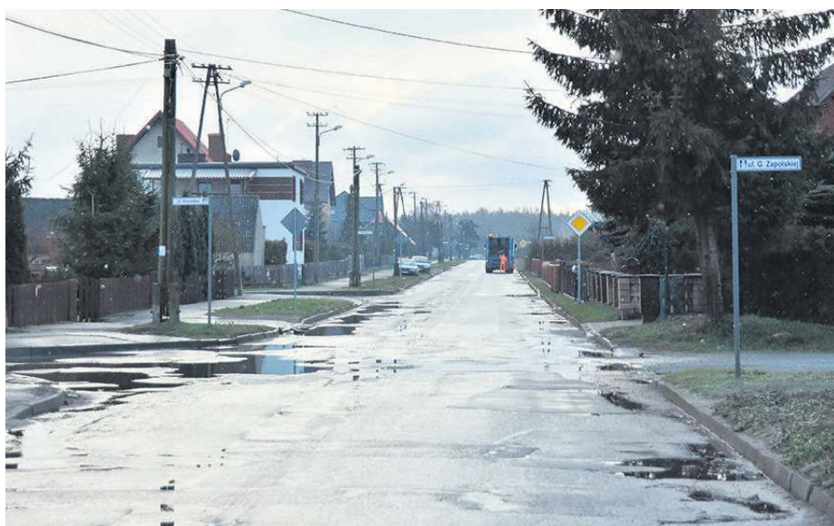
Ulica Mickiewicza. Co do ulic Mickiewicza i Wiejskiej gmina zamierza przygotować dokumentację projektową odnośnie przebudowy dróg.
