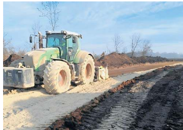
Ciężki sprzęt wyjechał już na plac budowy. Rozpoczęto pierwsze prace ziemne
