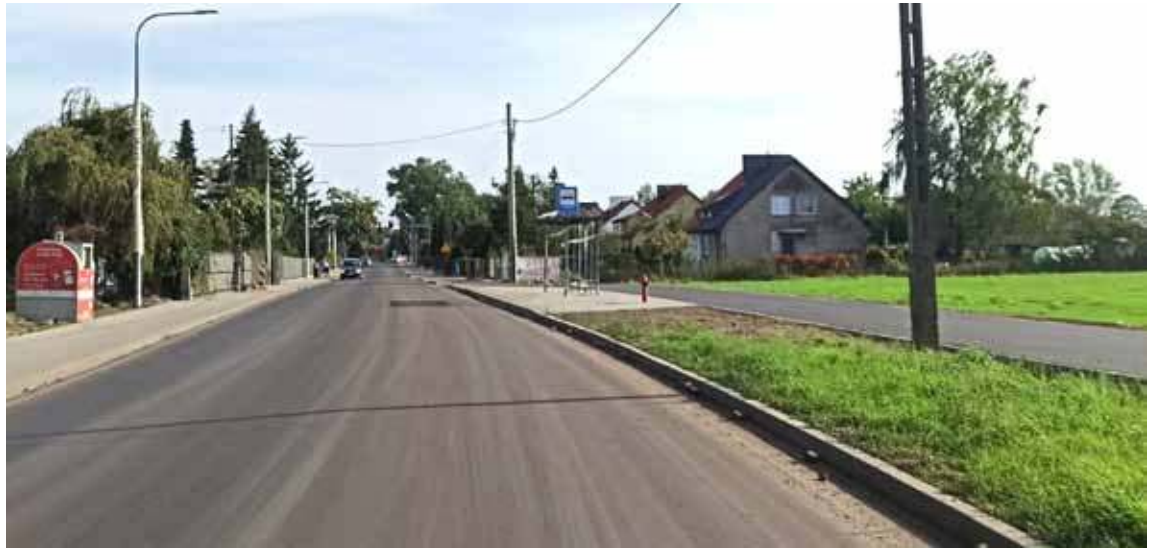
Na ul. Lotników i fragmencie ul. J. Lelewela gotowy jest już ciąg pieszo-rowerowy
