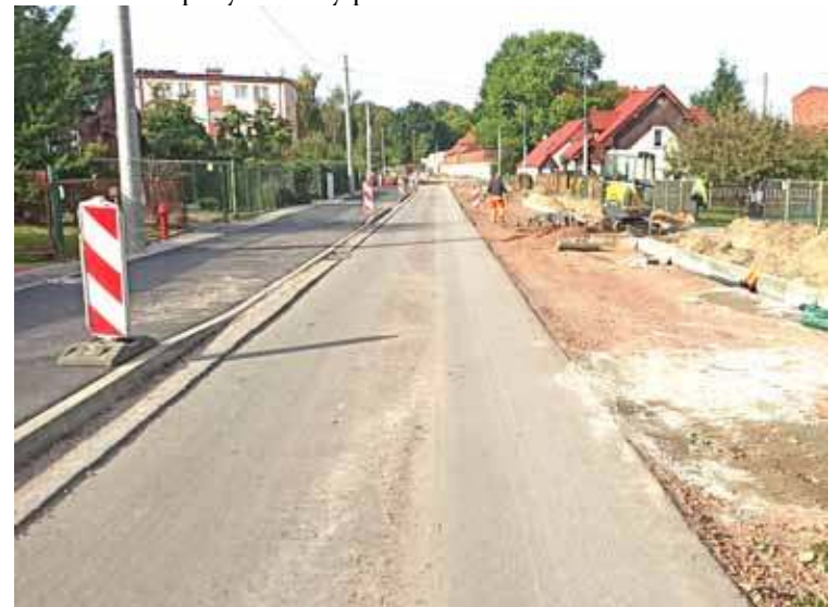
W sumie w Kluczewie wyremontowane zostanie 1,8 km dróg
