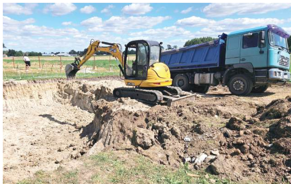
Na placu budowy rozpoczęto już prace
