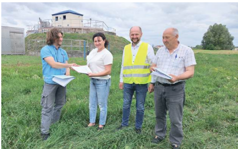
Przekazanie placu budowy
