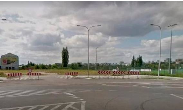
Budowa przedłużenia Trasy Zielonej stanęła pod znakiem zapytania
