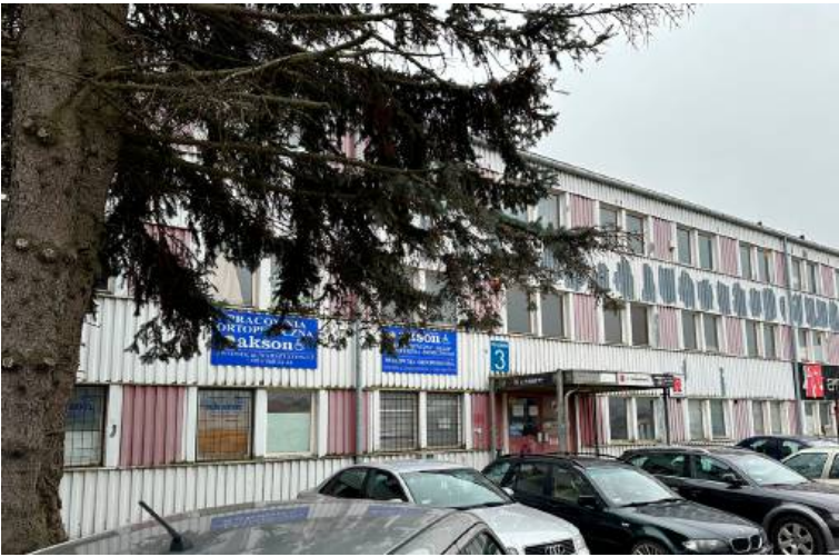
Opuszczony blaszany pawilon przy Warsztatowej 3 sprawia przygnębiające wrażenie
