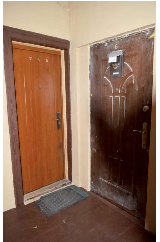
Ekipa remontowa nie zabezpieczyła drzwi wejściowych podczas prac na klatce
