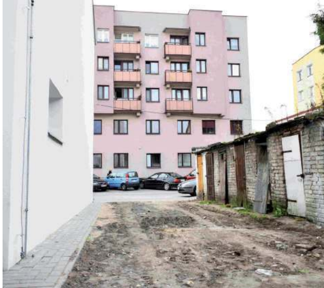
Nowa elewacja budynku kontrastuje z garażami
