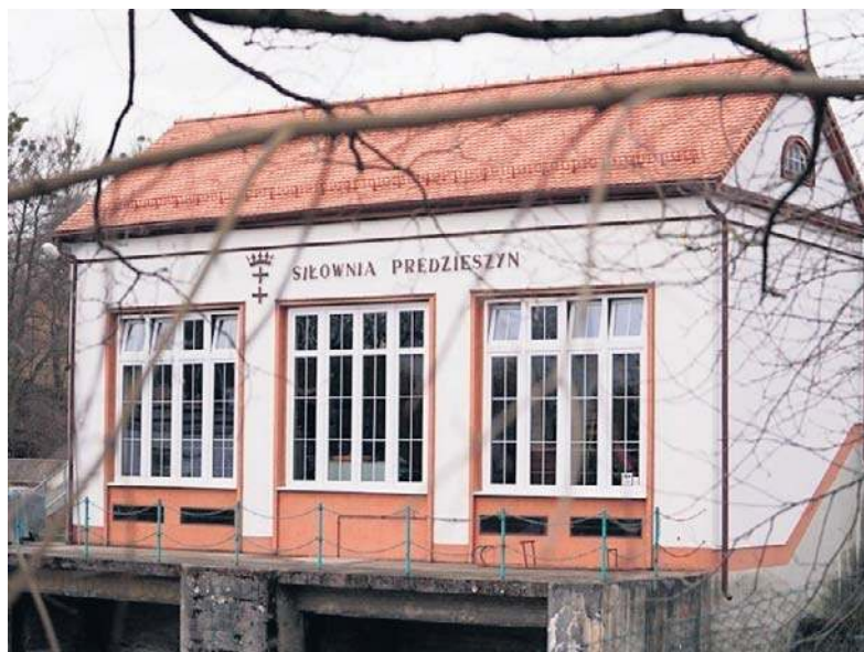
Elektrownię wodną w Przędziszynie uruchomiono w 1937 r.
